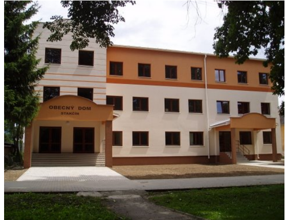
Budova Obecného domu (2007)
